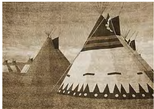
FIGURA 2. Tienda tipi. Utilizaban varillas de madera que se ataban en la parte superior formando una cubierta cónica, forradas de pieles de búfalo. Imagen extraída y redigitalizada de http://www.tipis.es , Morales, C. C. (2018).
