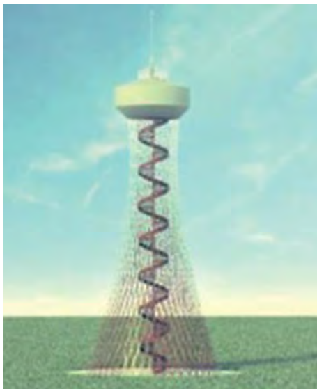
FIGURA 11. Torre de agua. La primer hiperboloide de celosía de 37 metros de altura por Vladimir Shukjhov, Nizhny. Novgorod, 1896. Imagen extraída y redigitalizada de https://regnum.ru , Morales, C. C. (2018).
