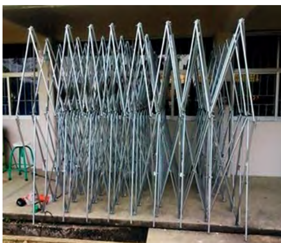
FIGURAS 299, 300. Una vez construido el paquete de aspas, se realizará el despliegado de la estructura en el sitio para comprobar sus despliegado y plegado de la cubierta transformable. Fuente: Morales, C. C. (2015a).
