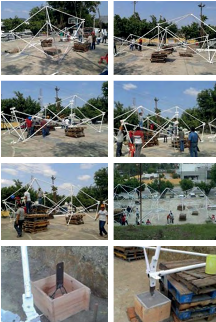
FIGURA 270 A LA 277. Evidencia fotográfica del prototipo: se desarrolló el armado de la estructura para verificar si ensamblan todas las piezas, esto ayudó a corregir algunos errores y desarrollar una estrategia constructiva de armado. Fuente: Morales, C. C. (2012a, 2014c).
