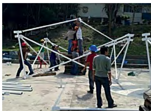
FIGURAS 264 A LA 269. Evidencia fotográfica del prototipo: esta primera parte del armado sirvió para colocarle una capa de Primer y pintura anticorrosiva para que en el armado del sistema no se fuese a oxidar. Fuente: Morales, C. C. (2012a).
