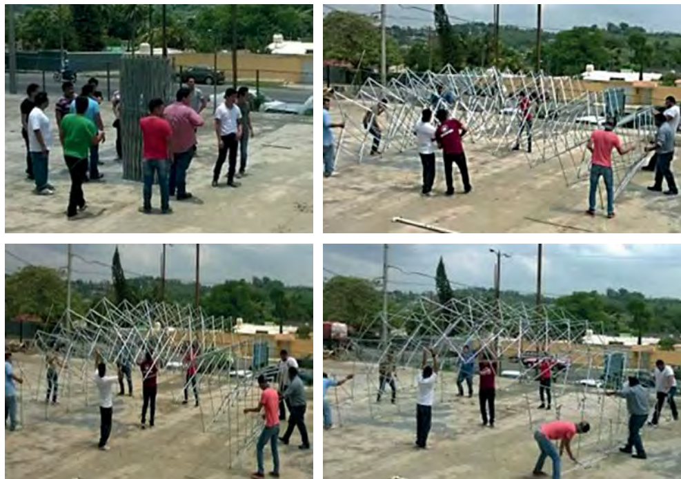
FIGURAS 301 A LA 304. El proceso de alzado ayuda a determinar cómo se comportaría el modelo en la construcción y cómo serían sus deformaciones en algunas partes de la cubierta, también se comprobó que se puede unificar el sistema transformable, ya que anteriormente está separada por la cubierta plegable y la geodésica como dos sistemas independientes, con esta práctica determinamos que pueden estar unidas. Fuente: Morales, C. C. (2015a).
