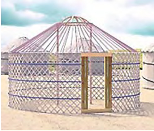
FIGURA 6. Instalación de un Ger o Yurts. Se une el enrejado circular en el que se coloca una cuerda en la parte superior para posteriormente sostener la cubierta. Imagen extraída y redigitalizada de http://www.canada-mongolia-connection.com , Morales, C. C. (2018).
