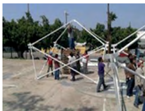
FIGURAS 264 A LA 269. Evidencia fotográfica del prototipo: esta primera parte del armado sirvió para colocarle una capa de Primer y pintura anticorrosiva para que en el armado del sistema no se fuese a oxidar. Fuente: Morales, C. C. (2012a).
