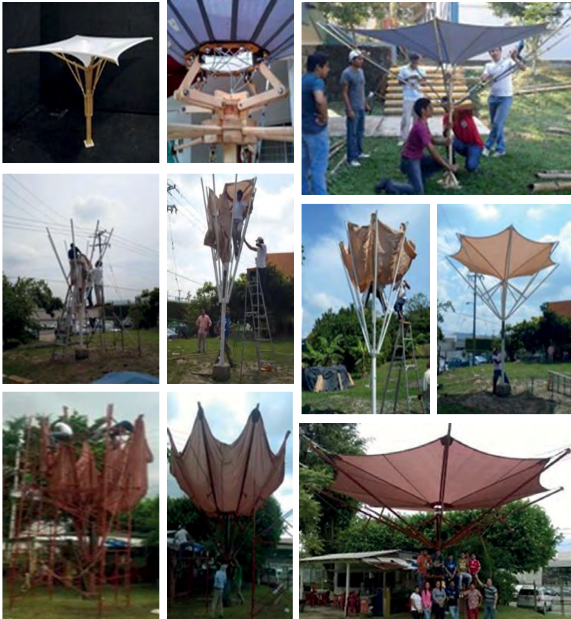
FIGURAS 312 A LA 321. Modelos prototipados para desarrollar geometrías complejas en los sistemas plegables desarrollados en el Laboratorio de Estructuras. Fuente: Morales, C. C. (2017).
